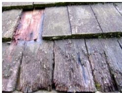
Bild 22: Trä som lösts upp av röta
