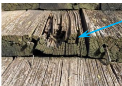
Bild 14-18: Skador på träspån orsakade av sprickbildning
