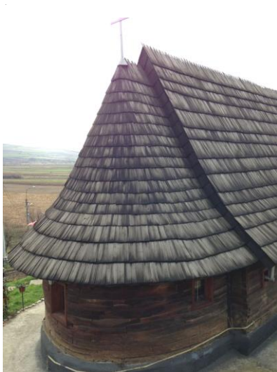
Bild 46: Kyrktak med grånade träspån
