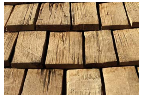
nytt tak av ekspån lagda med breda mellanrum
