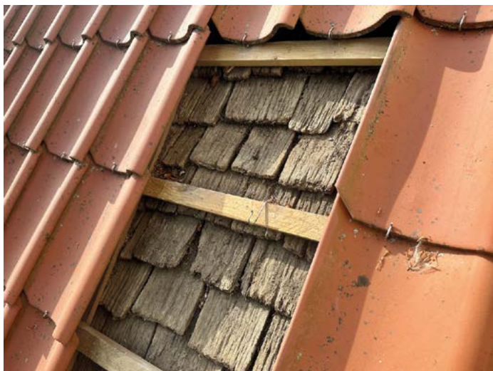
Spåntak av ek bevarat under tegelpannorna
